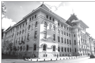
Fig. nr. 4 – Reconstruirea Palatului Ministerului Lucrărilor Publice din București în perioada 1948–1950. Construcția inițială (stânga) și supraînălțată (dreapta) [14]. Inginerul Dimitrie A. Stan a fost proiectant al planșeelor de beton armat.
