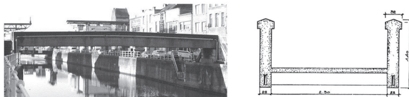
Fig. nr. 7 – Pasarela pietonală rue de Gosselies cu deschiderea de 21,00 m peste Canalul Charleroi-Bruxelles (prima construcție cu structură din beton precomprimat în sistem Blaton–Magnet, 1944). Elevație și secțiune transversală [3].
