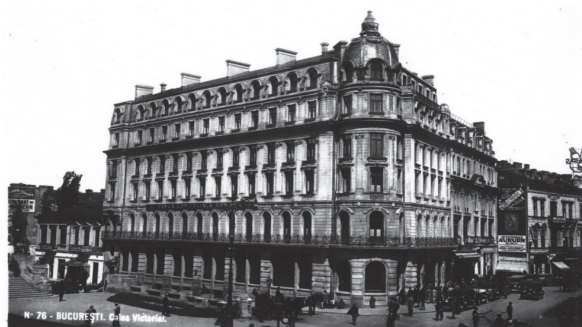
Fig. nr. 9 – Clădirea hotelului Luvru din București. Imagine din perioada interbelică [27].
