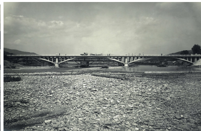
Fig. nr. 6 – Podul de beton armat peste râul Bistrița de la Buholnița, județul Neamț (F) [10], [19].
