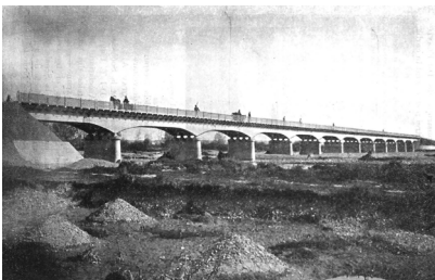
Fig. nr. 8 – Podul de beton armat peste râul Moldova de la Mălini, județul Suceava (H) [9]
