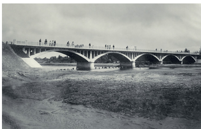
Fig. nr. 4 – Podul de beton armat peste râul Suceava de la Liteni, județul Suceava (D) [10], [19].
