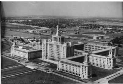
Fig. nr. 1 – Ansamblul de corpuri de construcție ale Combinatului Poligrafic „Casa Scânteii” din București (imagine din anul 1959) [21].
