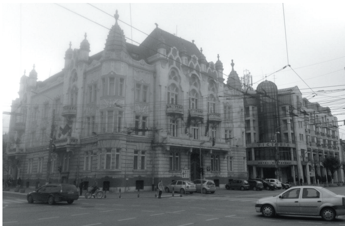
Fig. nr. 1 – Clădirea monument al Prefecturii Cluj (stânga) cu Hotelul Victoria alături
