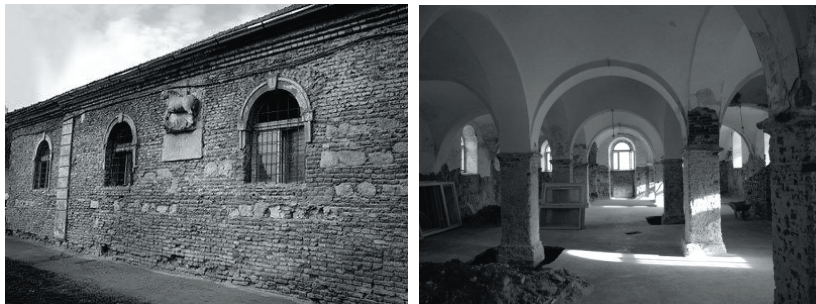
Fig. nr. 3 – Vedere exterioră și interioară a grajdului
