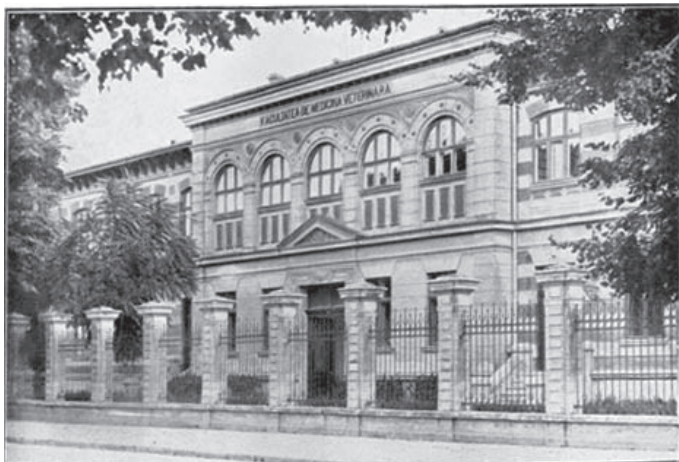
Fig. nr. 5 – Pavilionul central din campusul medical veterinar
