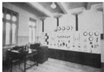
Sala de etalonare, curent continuu
