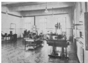
Sala de măsuri electrice industriale
