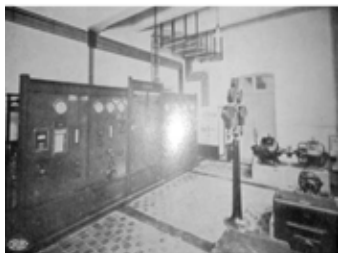
Sala tablourilor de distribuție
